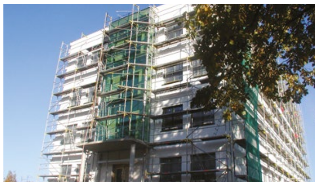
Budowa siedziby KPSW przy ul. Toruńskiej 55-57 (rok 2006)
